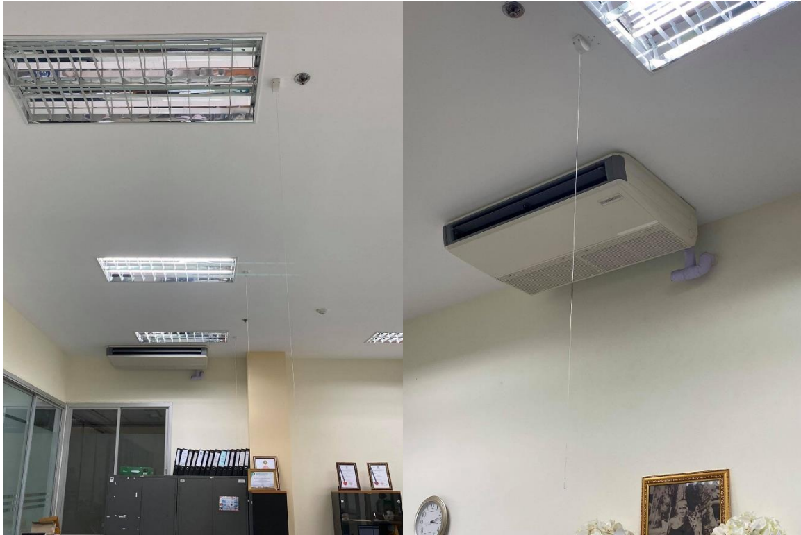
การติดตั้งสวิทช์กระตุกสำหรับการประหยัดพลังงานเฉพาะพื้นที่
