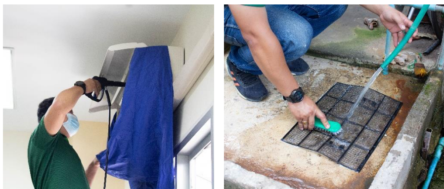
ภาพถ่ายกิจกรรมการล้างเครื่องปรับอากาศ ครั้งที่ 2 ในช่วงเดือน พฤษภาคม 2564 โดยบุคลากร
