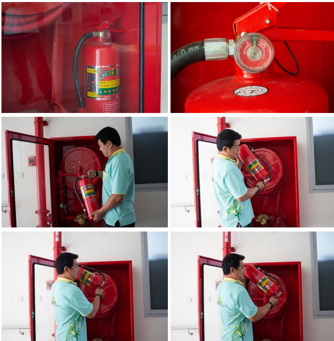
ภาพ การตรวจถังดับเพลิง
