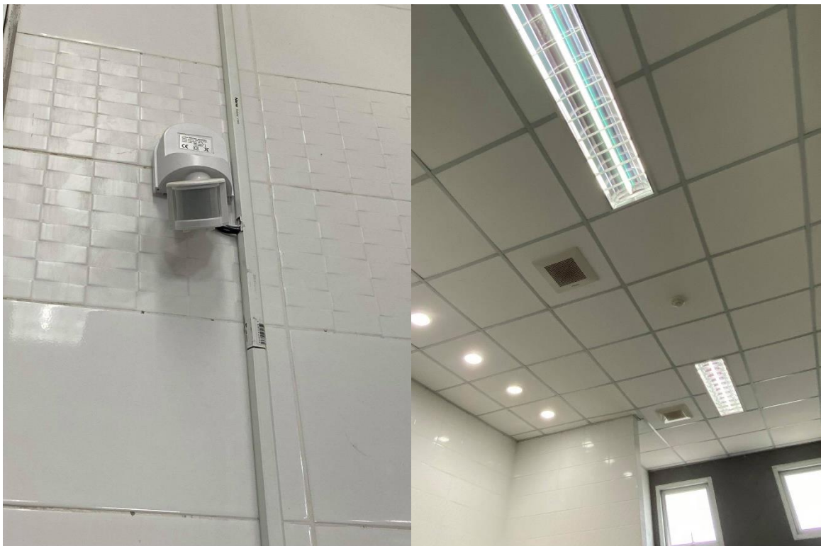
เซ็นเซอร์ไฟส่องสว่างในห้องน้ำ เปิด ปิด อัตโนมัติ พร้อมระบบแสงสว่างและพัดลมระบายอากาศ
