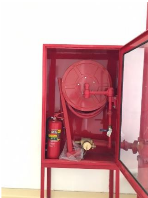
ภาพแสดงที่ติดตั้งถังดับเพลิง
