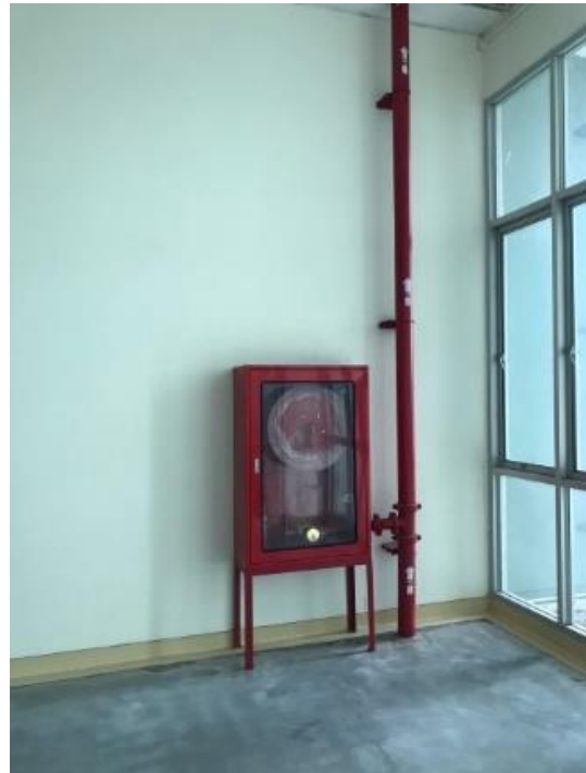
ภาพ แสดงพื้นที่ตั้งถังดับเพลิง สายดับเพลิงที่ไม่มีสิ่งกีดขวาง
