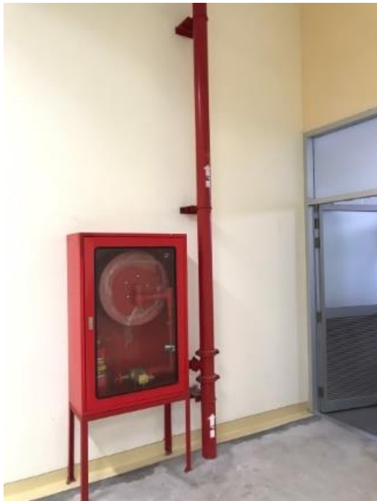
ภาพ แสดงพื้นที่ตั้งถังดับเพลิง สายดับเพลิงที่ไม่มีสิ่งกีดขวาง
